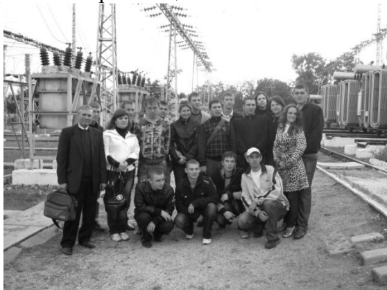
Візне заняття на тяговій підстанції
